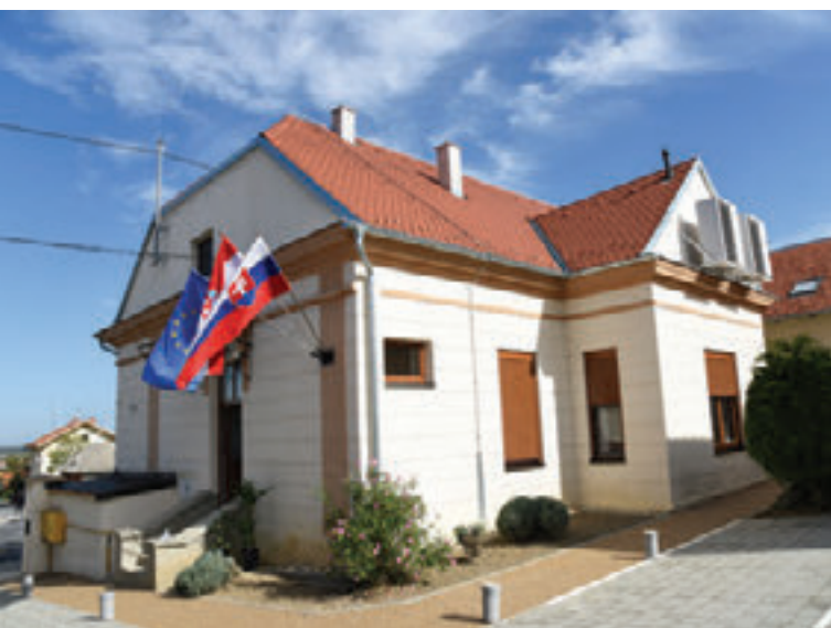
Budova Slovenského kultúrneho centra Našice / Zgrada Slovačkog centra za kulturu Našice
